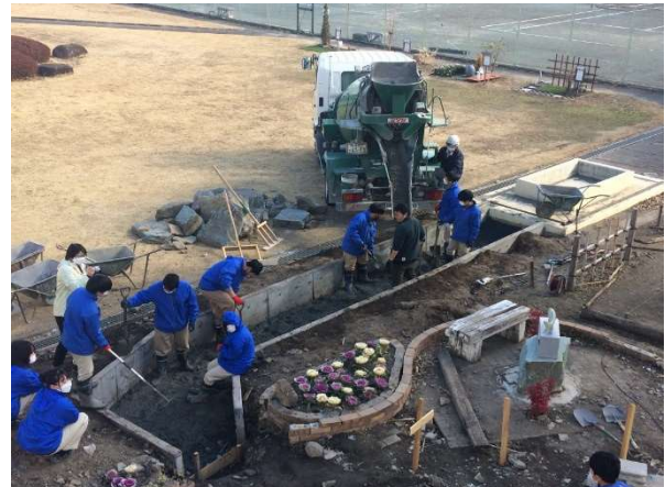
水路のコンクリート打設 (2021.11月)
