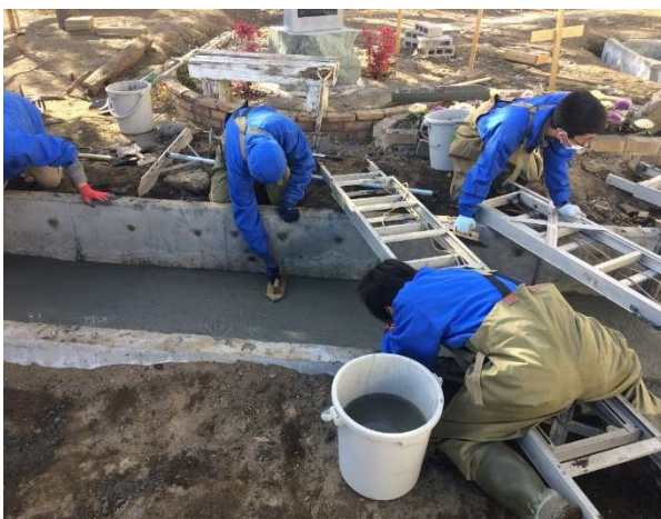
水路へのコンクリート打設 (2021. 12月)
