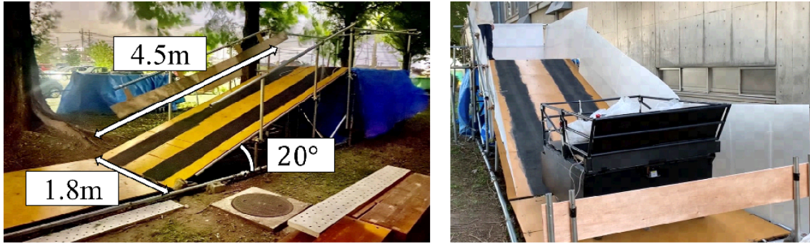
Fig. 6.37: 急勾配のスロープ環境
