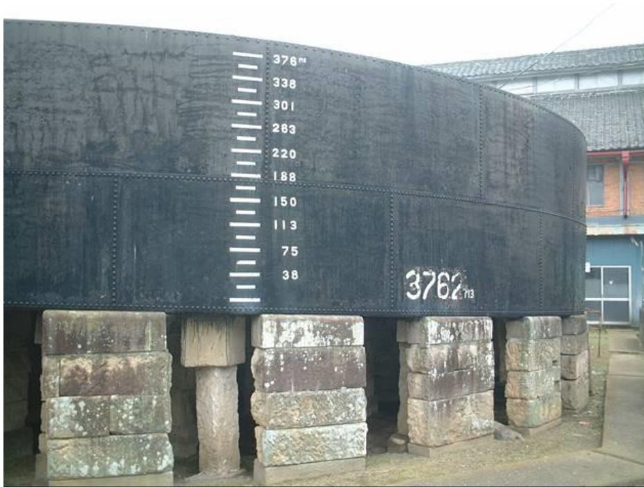
写真 3.3.1 富岡製糸場の鉄水溜（筆者撮影）
