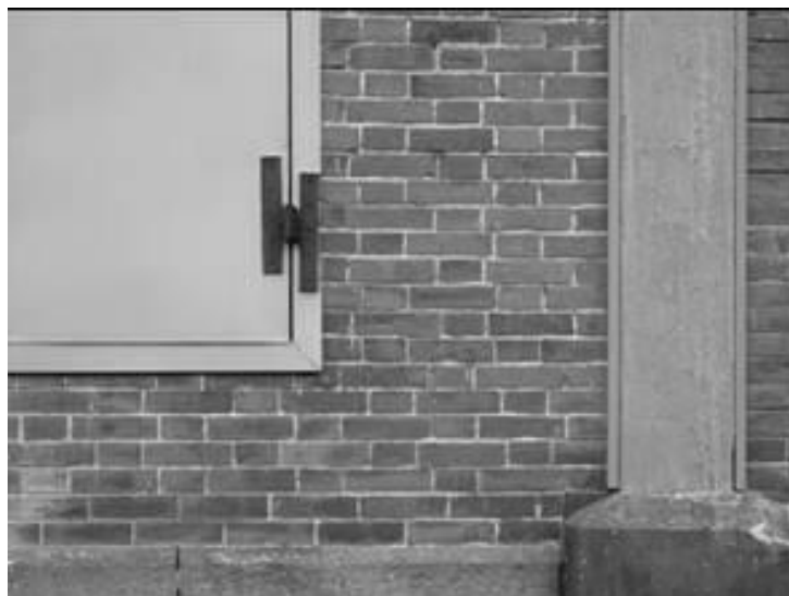
写真 4.3.2 木骨煉瓦造 注9) とフランス積 注10) (東繭倉庫, 筆者撮影)
