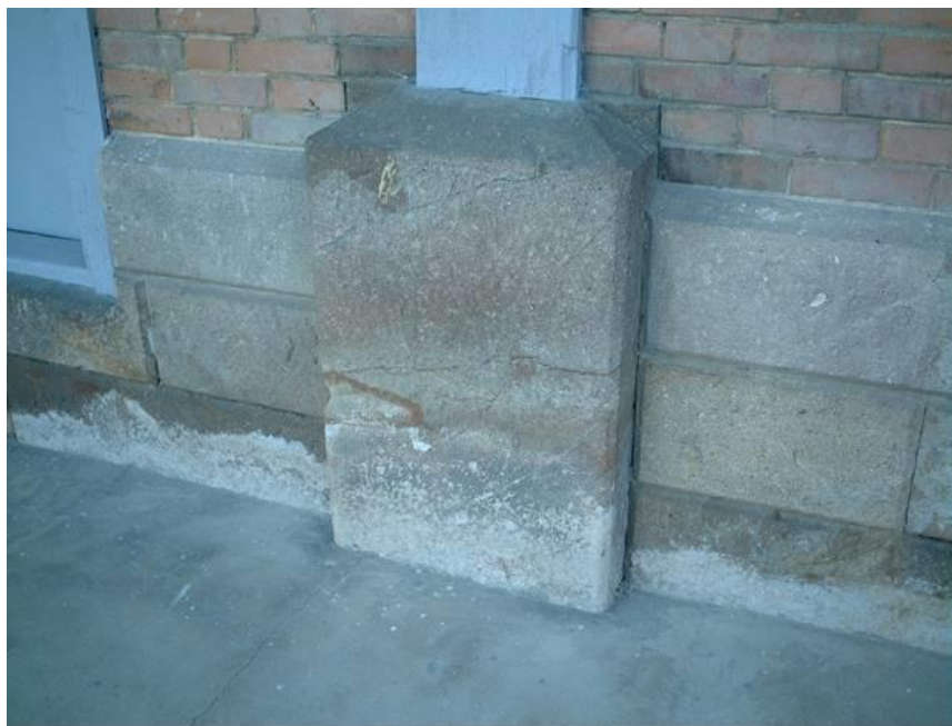
写真 4.2.2 富岡製糸場の柱の礎石（東繭倉庫，筆者撮影）
