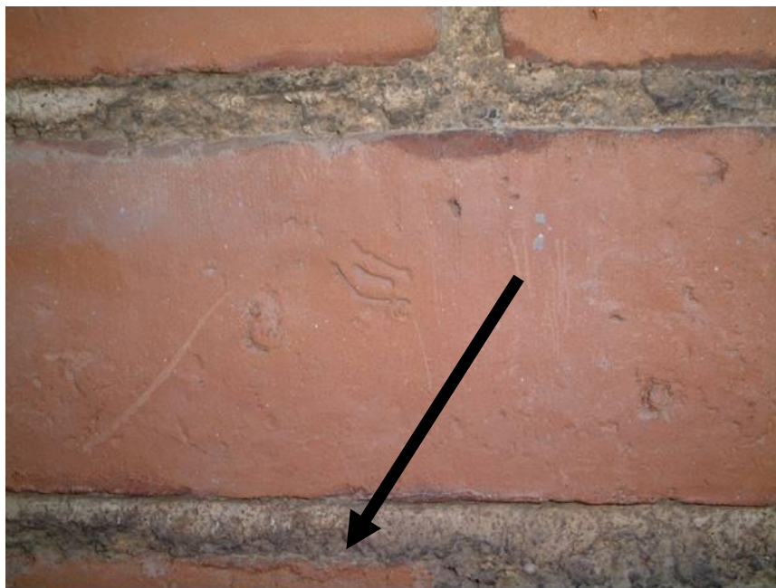
写真 4.2.5 富岡製糸場の煉瓦の目地（東蘭倉庫，筆者撮影，加筆）
