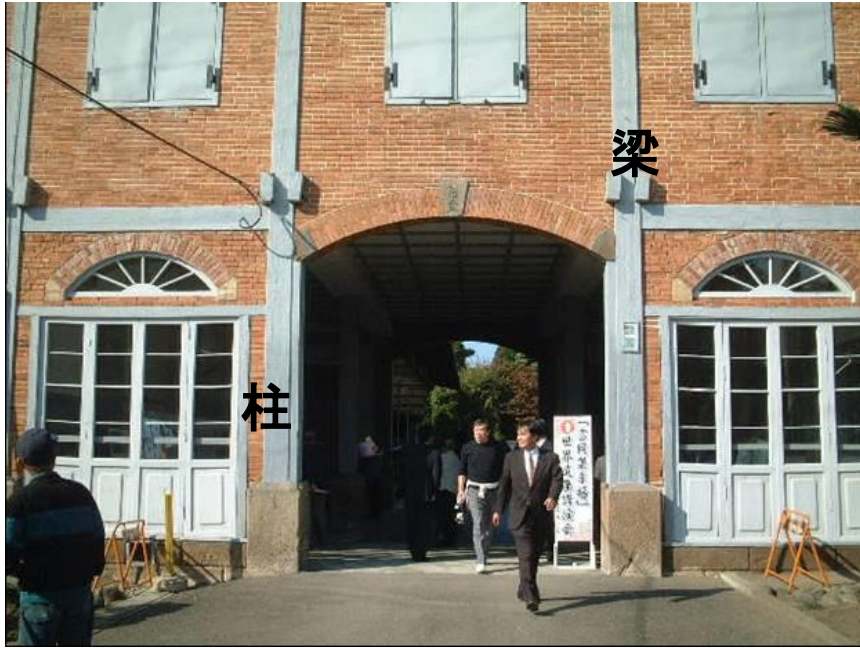
写真 4.2.3 富岡製糸場の東蘭倉庫の柱と梁（筆者撮影，加筆）
