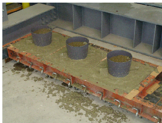
(4) N135N 試験体のコンクリート打設
