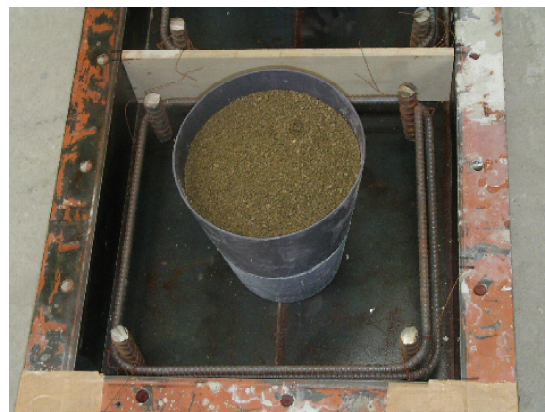
写真3.4 試験体の作製状況 (N90 試験体)
