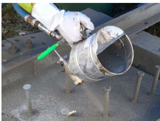
写真-5.1 施工状況（その1）
