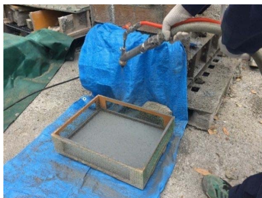
写真-5.2 施工状況（その2）
