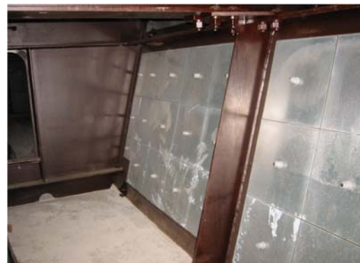
(b) 箱桁腹板内側に設置された例
