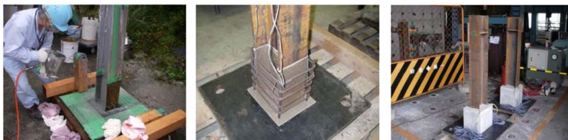
(a) PCM吹付施工状況 (b)PCM硬化後・配筋設置 (c) 早強コンクリート打設・硬化後 写真-6.1 複合構造化施工状況 (各供試体共通)
