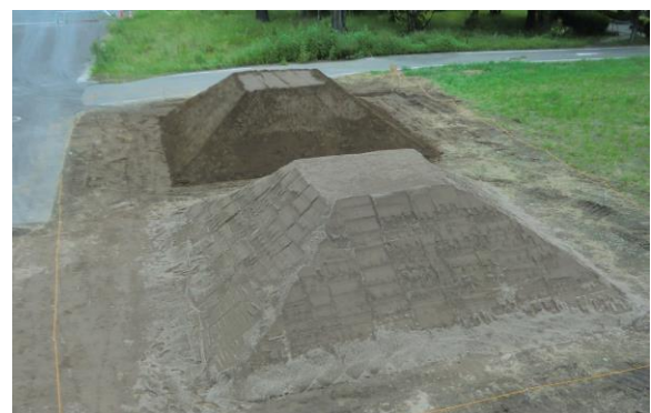
写真 1 築造した盛土(奥: 砂質土, 手前: 砂)
