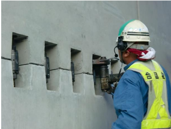
専用電動工具による締付
