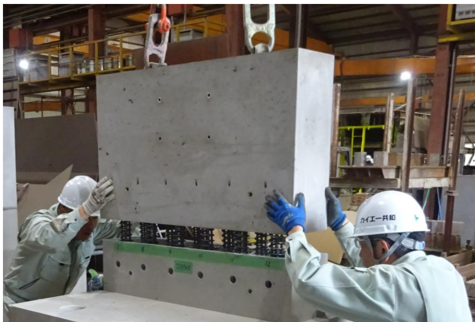
写真-7.6 部材の接合状況 (試験体 JD13B-第6章)
