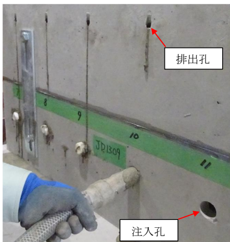
写真-7.4 注入孔と排出孔
