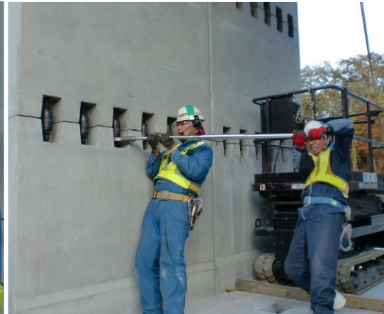
トルクレンチによるトルク確認
