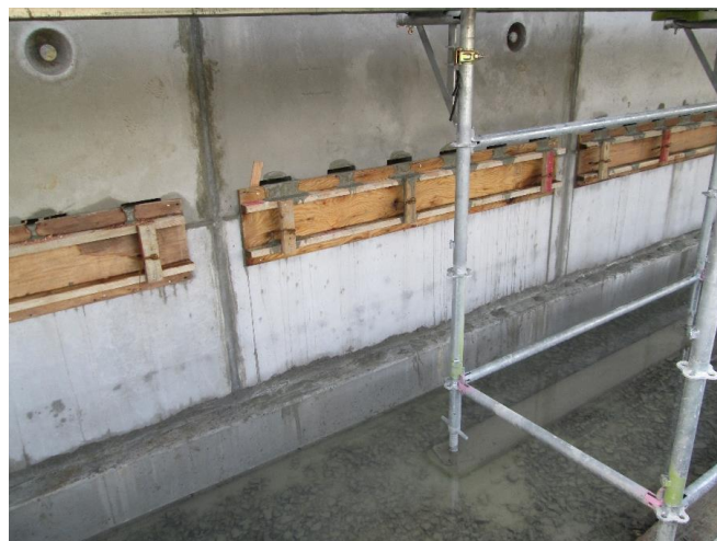
写真-7.5 開口部の型枠設置
