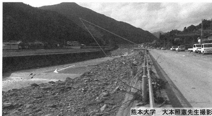
図-2.5 小野川の上流域における山腹斜面崩壊の状況
