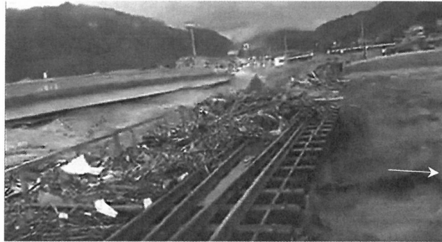
図-2.4 久大本線鉄道橋上部の流木の堆積と越水の状況 25)加筆
